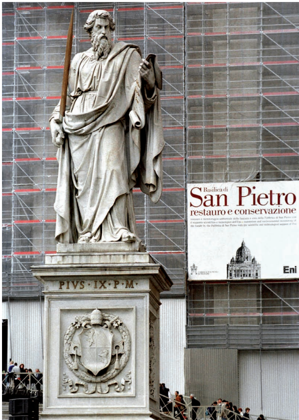
Paulus-Statue vor dem Baugerüst der Peterskirche auf dem Petersplatz in Rom (1999)
