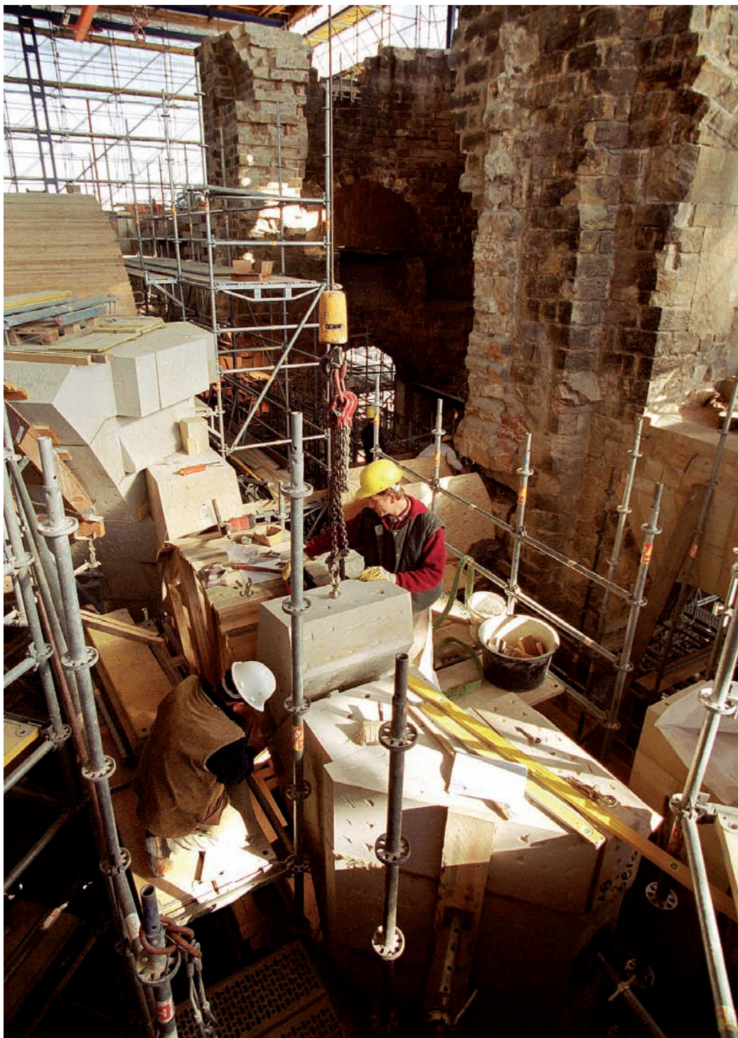
Wiederaufbau der Frauenkirche in Dresden
