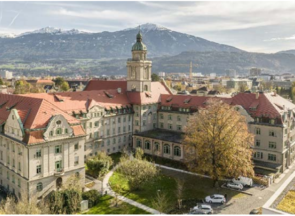
Nach Sanierung fit für die Zukunft: Canisianum Innsbruck
